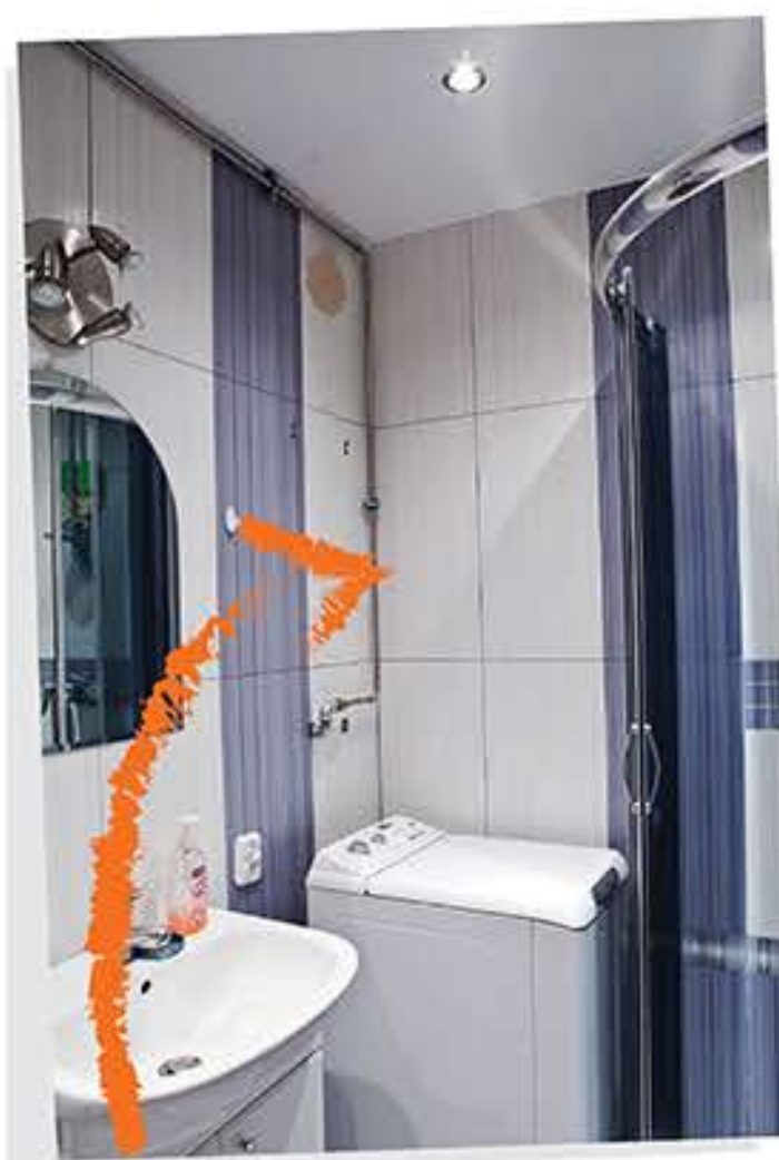
Budowa nowej instalacji i połączenie z instalacją istniejącą już w mieszkaniu
