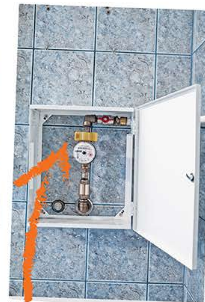
Montaż skrzynki pomiarowej, prace wykończeniowe i uruchomienie ciepłej wody użytkowej
