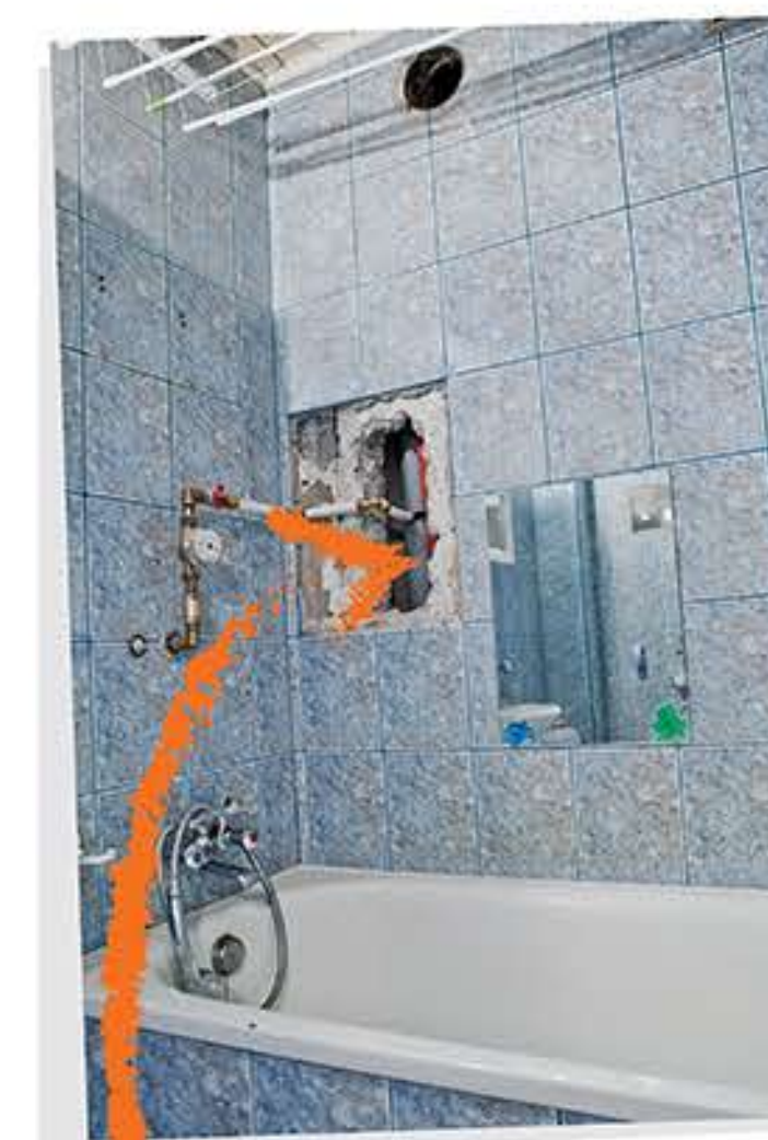
Budowa nowej instalacji w kominie i połączenie z instalacją istniejącą już w mieszkaniu
