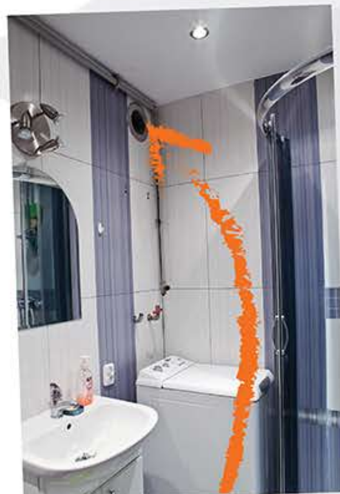
Demontaż starego piecyka gazowego i likwidacja instalacji
